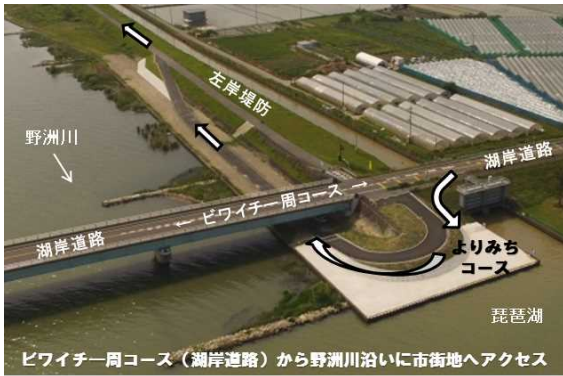
図-12 河口部管理用通路完成状況（左岸河口部上空より）
