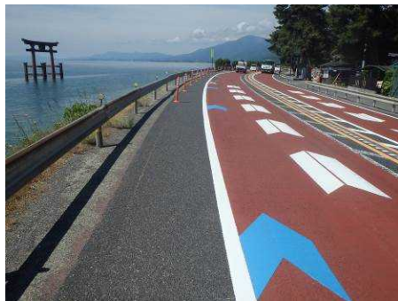
図-4 自転車通行帯整備事例（R161, 矢羽根型路面表示）
