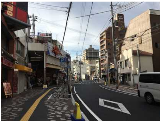
図-6 アーケードの撤去と駐輪ラックの設置
