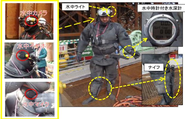
図-13 潜水作業時の装備と水中カメラの映像共有状況
