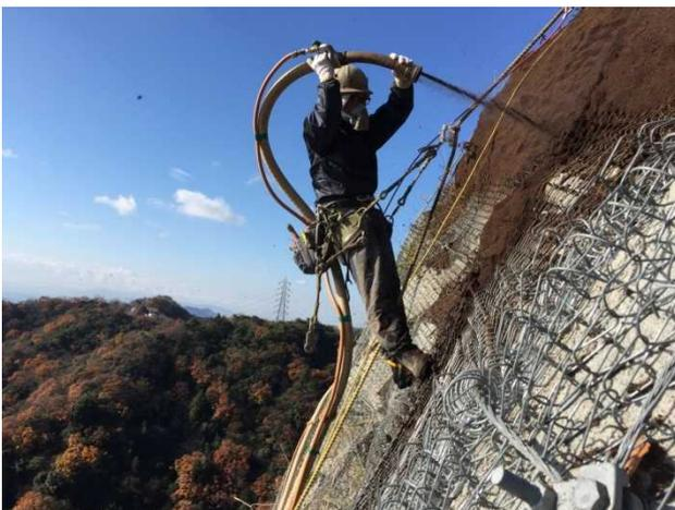
写真-8 本施工における吹付施工状況
