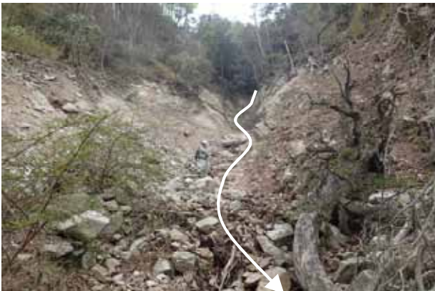
写真-1 地震による崩壊残土を含む溪床堆積物の侵食状況
