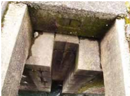
図-20 旧洗堰1号水通し部
