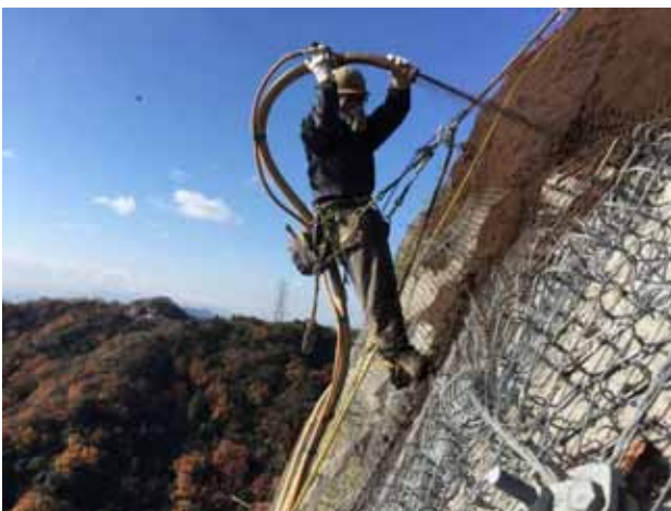
写真-8 本施工における吹付施工状況
