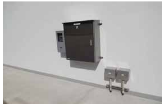
図4-5 外部電源接続箱図
