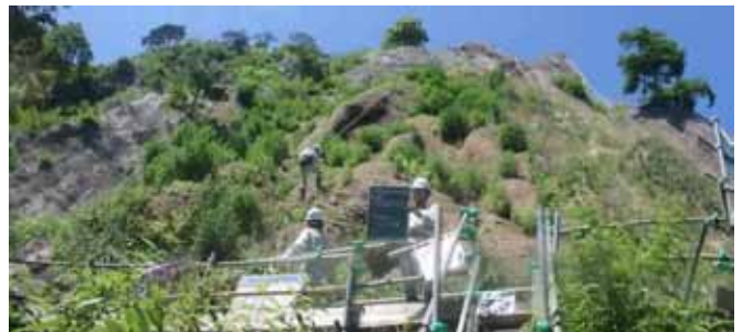
写真-6 試験施工の追跡調査状況 2016年7月
