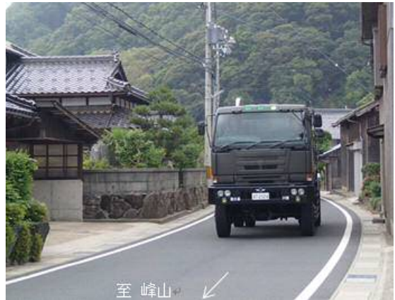
図-8 現道の状況
