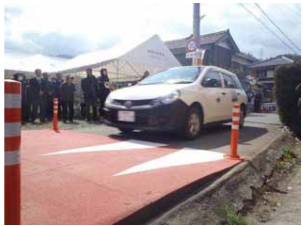
写真-5 ハンプ設置後の試走の様子
