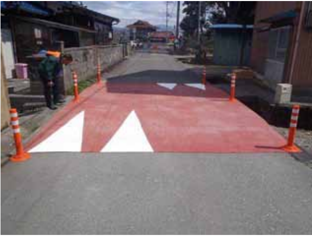
写真-4 ハンプ設置完了
