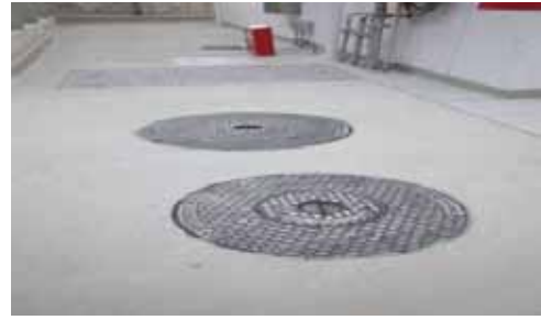
図4-4 地下タンク埋設(2000L)
