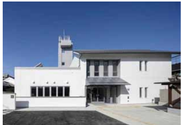
図1-2 奈良地方気象台(東側) (新築)
