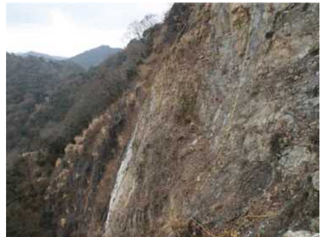
写真-3 垂直に近い急勾配岩盤斜面の近景
