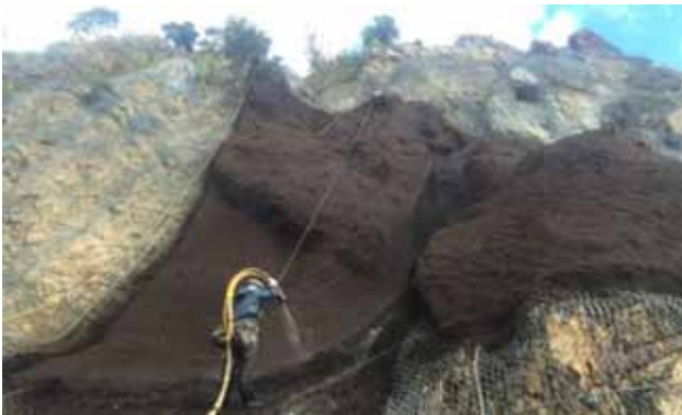
写真-4 試験施工実施状況
