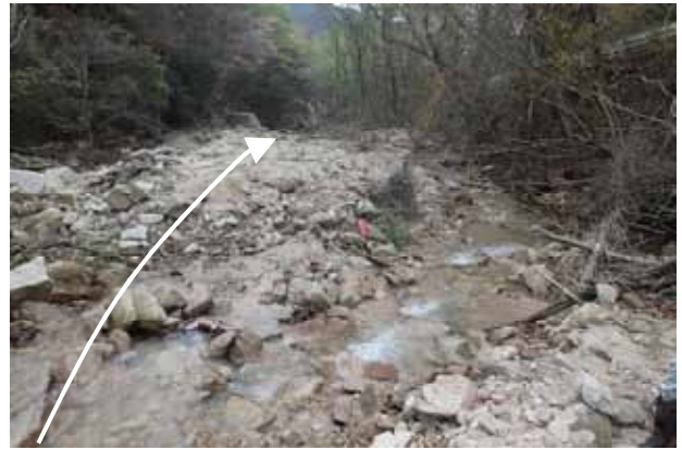
写真-3 下流河川に設置された不透過型砂防堰堤堆砂地の状況
