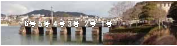
図-16 旧洗堰左岸 (平成 28 年 4 月撮影)
