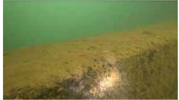
図-21 6号水通しに存置されている石桁
