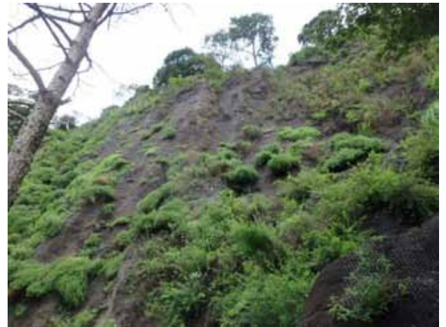
写真-1 近接する施工済み箇所近景 2014年6月
