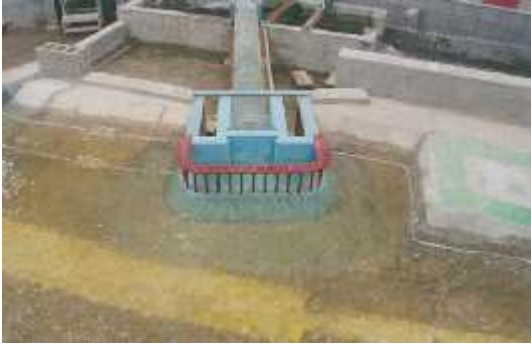
図-21 導水トンネル呑口部
