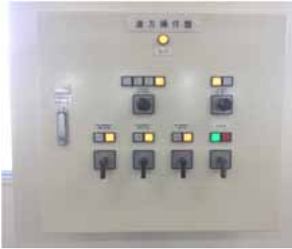
図4-6 遠隔操作盤
