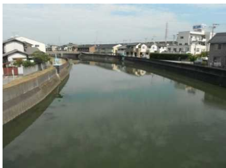
図-4 現況写真(対汐橋上流付近)
