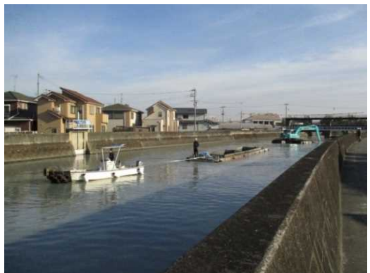
図-9 土運船による運搬状況
