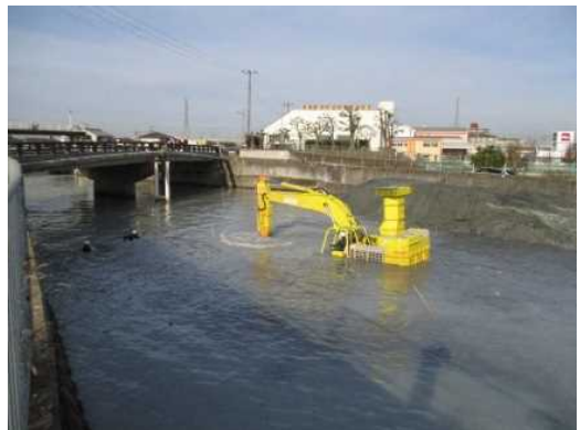
図-8 水陸両用掘削機による掘削状況
