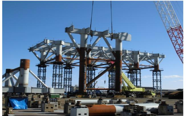
写真-2 ジャケットの工場製作状況
