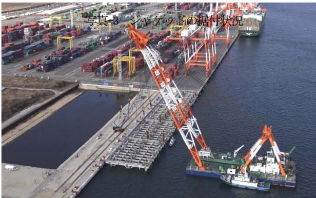
写真-3 ジャケットの据付状況
