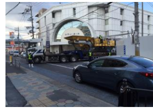
写真28—解体工事での大型車両の通行状況
