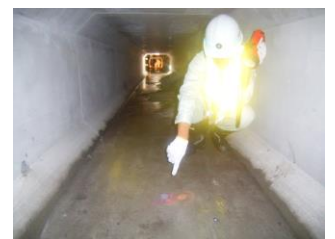
写真25-底部注入孔確認
