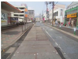
写真26—覆工板設置
