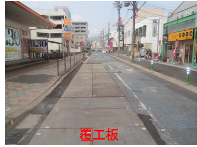
写真15ー覆工板設置での通行状況
