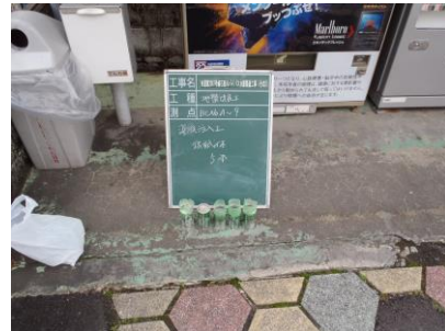
写真23-テストピース採取
