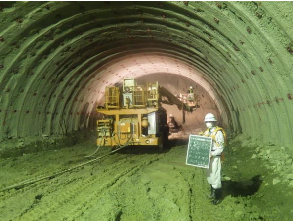
写真-5 支保 No.125 の補助工法施工状況
