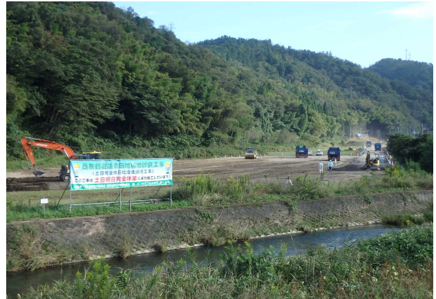
写真-1 土日完全週休2日試行工事の工事状況
