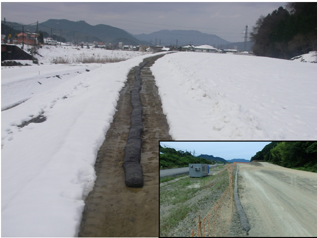
写真-2 工事完成間際の積雪状況
