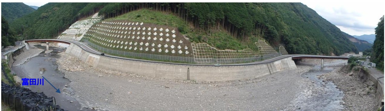
写真-5 ステップ3(完成状況)
