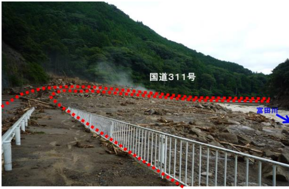
写真-1 被災当初の国道、富田川状況
