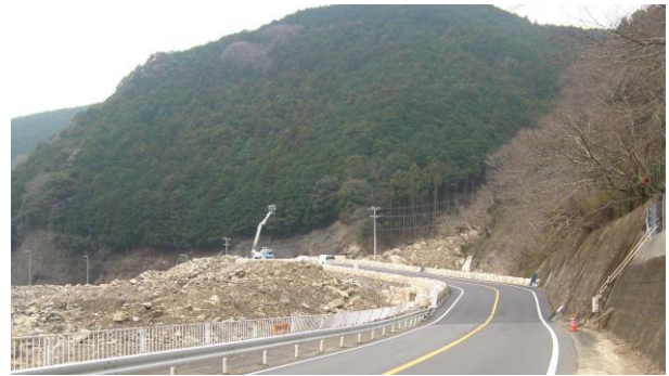
写真-3 ステップ1（応急仮設道路）
