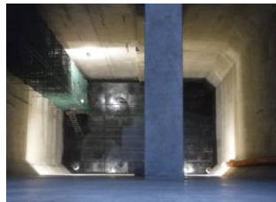
写真-8 立坑底部 鉄板補強状況
