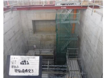
写真-10 浮き足場・昇降設備
