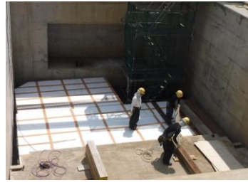
写真-9 浮き架台施工状況
