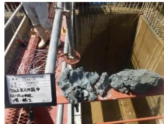
写真-3 硬質粘性土
