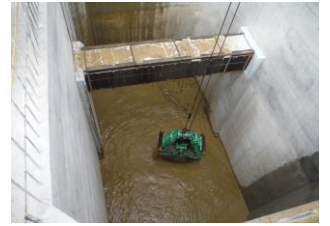
写真-2 水中掘削状況
