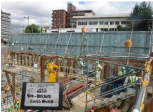
写真-7 立坑底部周囲 薬液注入施工状況
