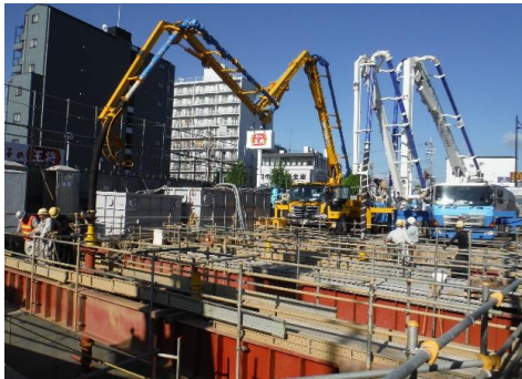
写真-6 水中コンクリート打設状況
