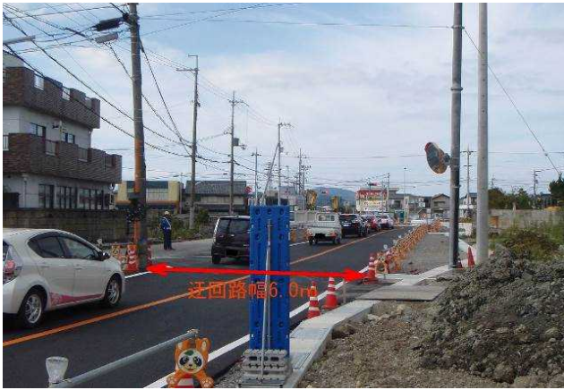
写真-3 電柱残置部 STEP2 迂回路
