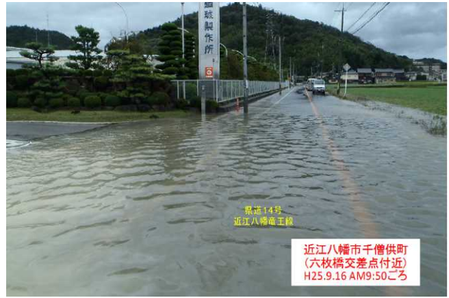
写真-4 台風18号・冠水状況
