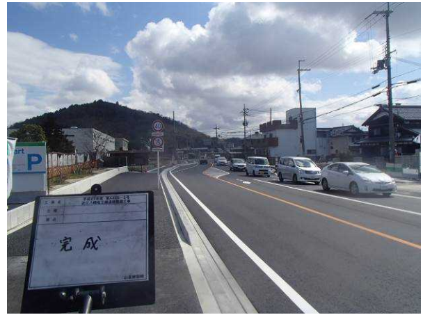
写真-5 工事完了・供用開始状況
