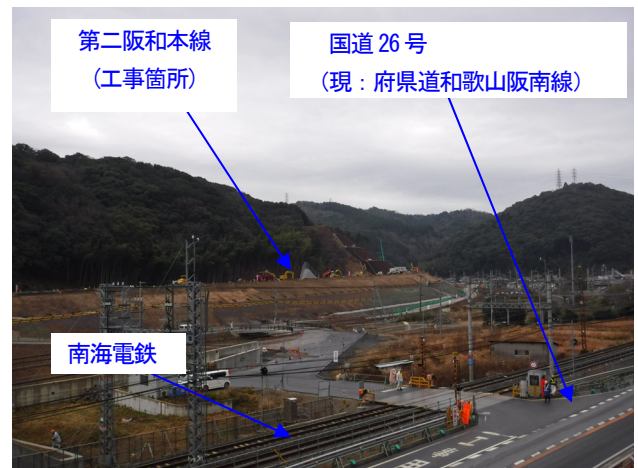
図-2 第二阪和国道の現場状況
