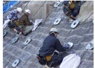
写真-7 ワイヤー連結工施工状況
