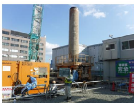
図-6 ストレーナーの施工状況 図-7 VPRWの施工状況
