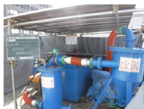
図-6 ストレーナーの施工状況 図-7 VPRWの施工状況
