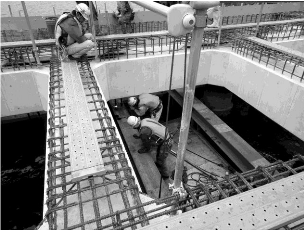
写真4 支保工撤去状況
