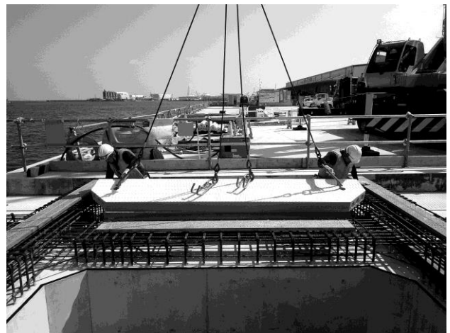
写真8 埋設型枠据付け状況
