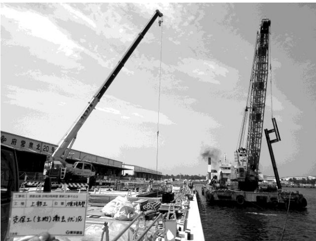
写真5 支保工撤去状況
