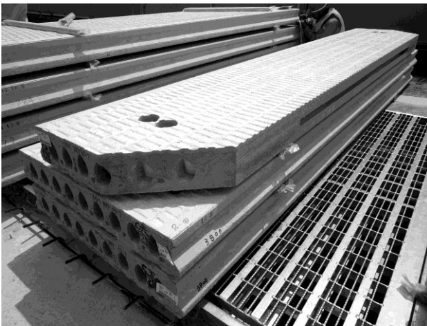
写真-3 埋設型枠
