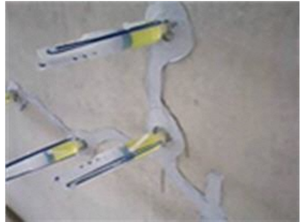
写真-1 低圧注入工法の施工状況
