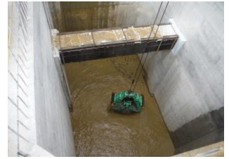
写真-2 水中掘削状況
