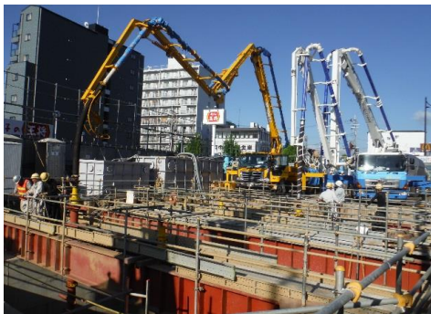
写真-6 水中コンクリート打設状況
