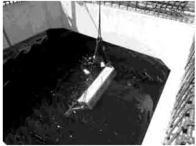
写真6 陽極取付状況
