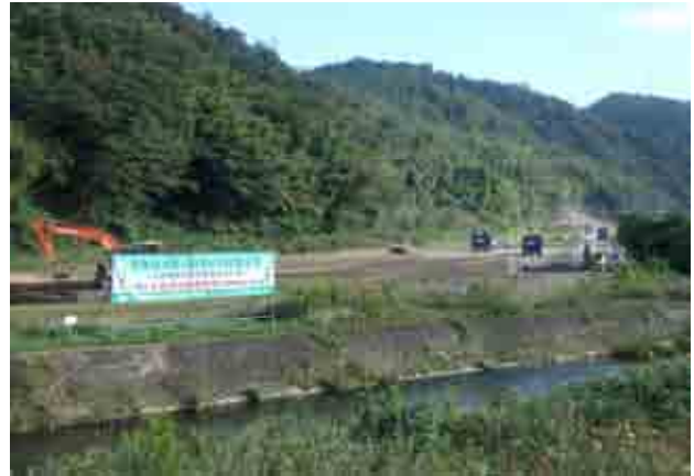
写真-1 土日完全週休2日試行工事の工事状況
