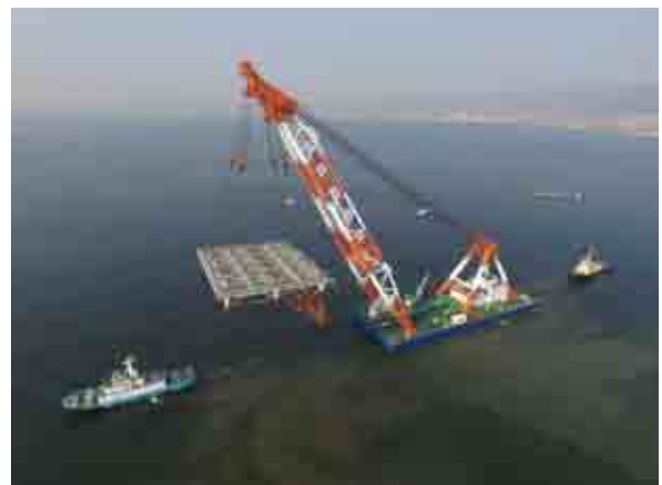
写真-7 ジャケットの曳航状況
