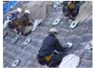
写真-7 ワイヤー連結工施工状況
