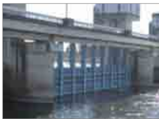
写真3 予備ゲート設置状況
