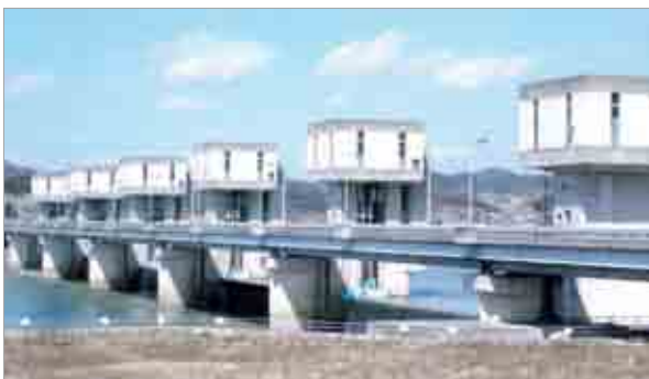
写真1 加古川大堰全景（左岸下流より）
