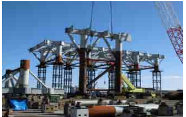
写真-2 ジャケットの工場製作状況
