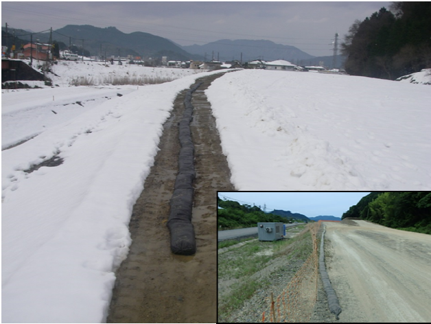
写真-2 工事完成間際の積雪状況
