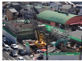
写真-1 掘削状況全景
