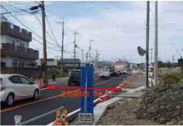
写真-3 電柱残置部 STEP2 迂回路
