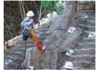
写真-6 布設状況と散水固化状況
