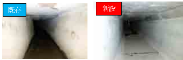
石田川 1.4m/1.0m×1.2m バイパス水路 1.3m×1.0m 写真3-内空写真
