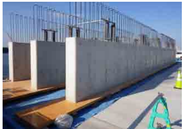
写真-10 陸上製作した栈橋上部工前面部
