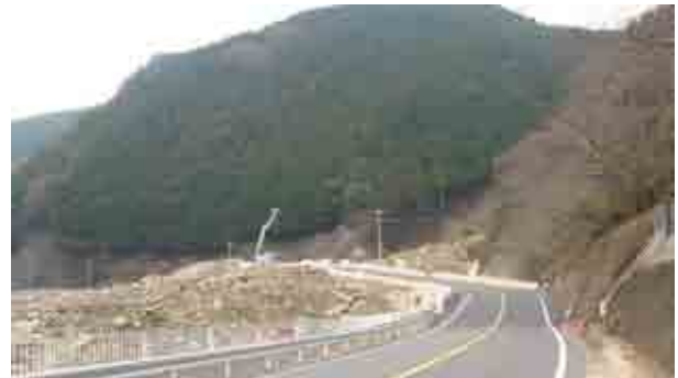
写真-3 ステップ1（応急仮設道路）
