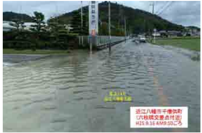
写真-4 台風18号・冠水状況
