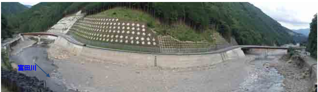
写真-5 ステップ3 (完成状況)
