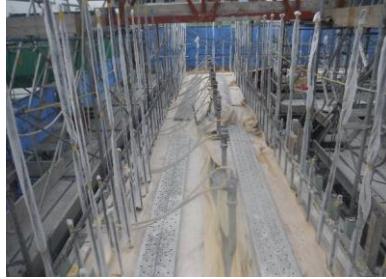
写真-5 パイプクーリング状況
