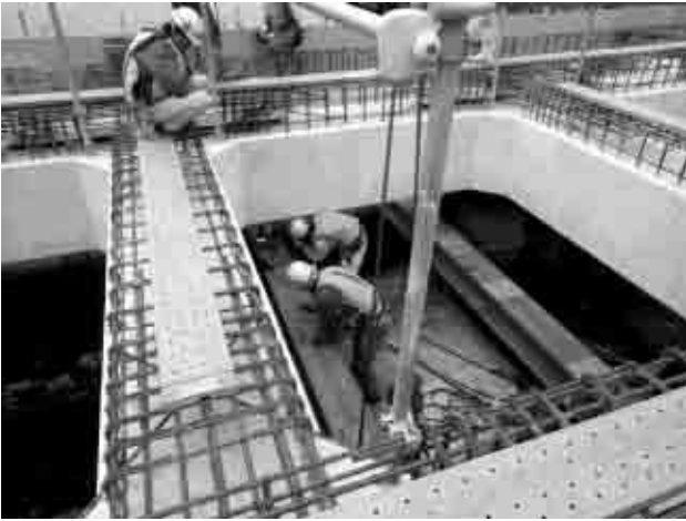
写真4 支保工撤去状況
