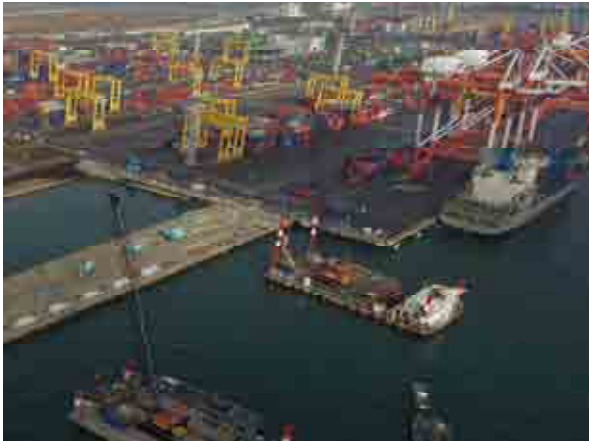
写真-6 供用中C-12コンテナ船との近接施工
