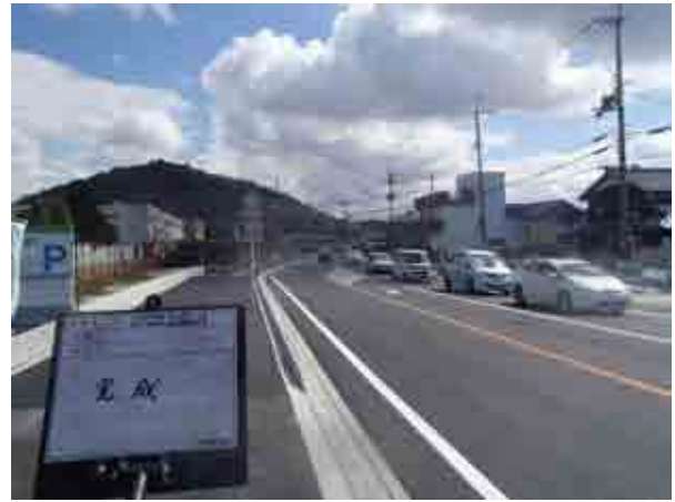
写真-5 工事完了・供用開始状況
