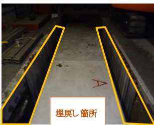
写真13ー埋戻し箇所
