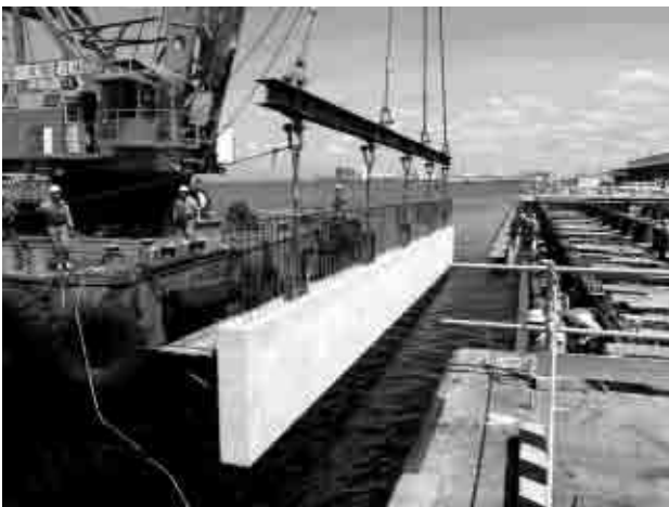
写真-11 前面部プレキャストコンクリート据付状況
