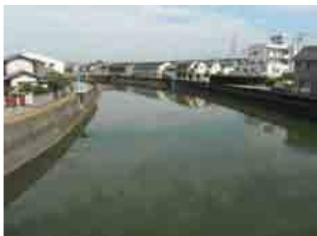
図-4 現況写真(対汐橋上流付近)
