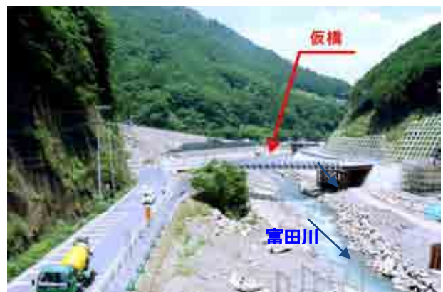
写真-4 ステップ2 (仮設道路 中国地方整備局から仮橋を借用)
