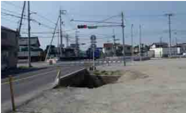
写真-2 旧三明川閉塞箇所(本工事閉塞箇所①)
