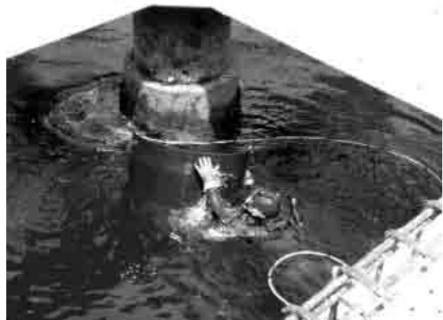
写真7 被覆防食施工状況
