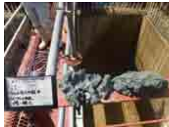
写真-3 硬質粘性土
