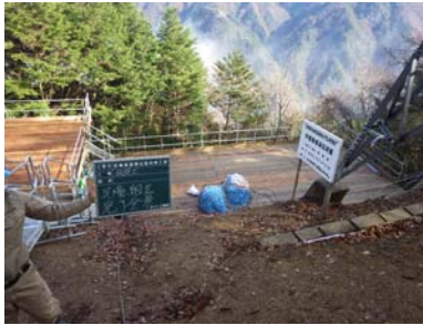
写真-4 荷受足場組立完了
