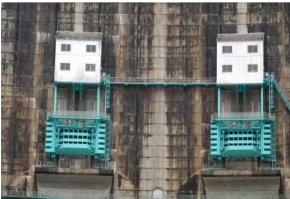
写真-1 主放水ゲート正面
