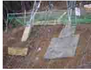
写真-6 布設状況と散水固化状況
