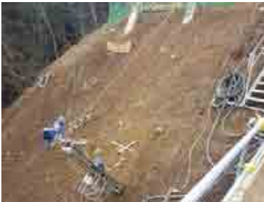
写真-5 無足場法面削孔機による削孔状況
