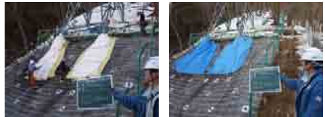
写真-12 基礎被覆工における養生状況
