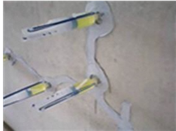
写真-1 低圧注入工法の施工状況
