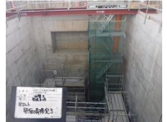
写真-10 浮き足場・昇降設備
