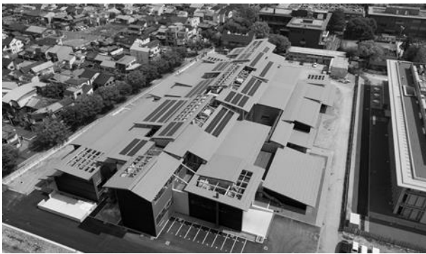
図1 新総合資料館（仮称）全景
