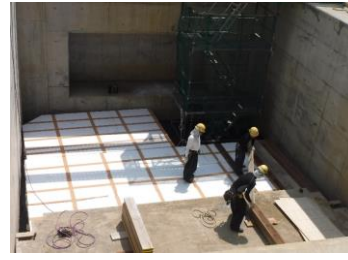
写真-9 浮き架台施工状況
