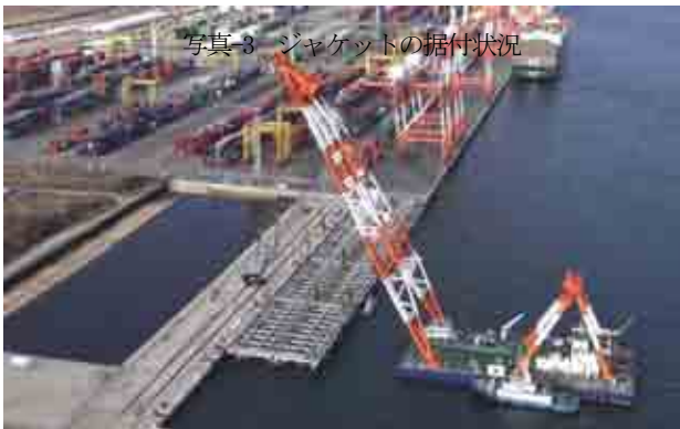
写真-3 ジャケットの据付状況
