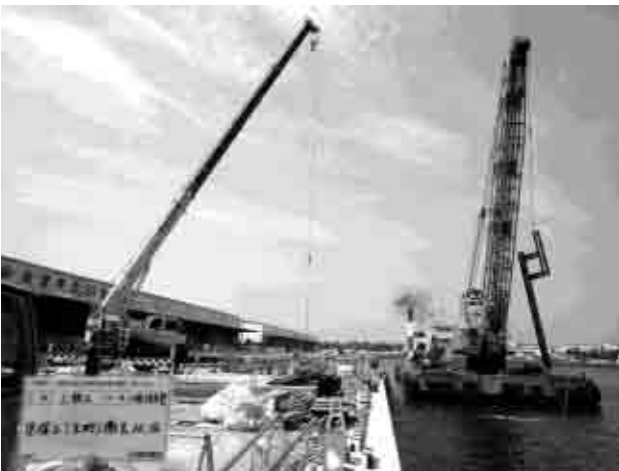
写真5 支保工撤去状況
