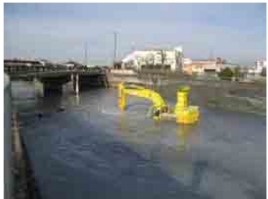
図-8 水陸両用掘削機による掘削状況
