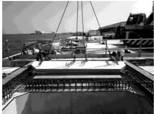
写真8 埋設型枠据付け状況
