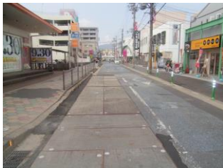
写真26—覆工板設置
