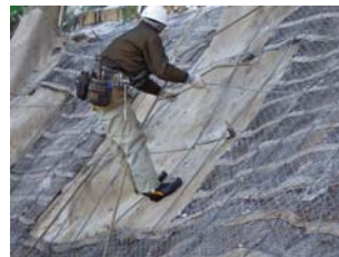
写真-7 ワイヤー連結工施工状況
