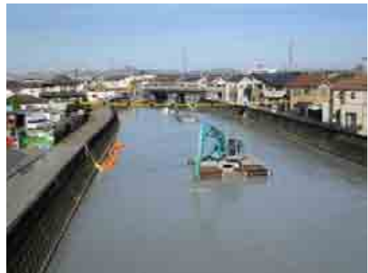
図-7 泥上掘削機による掘削状況
