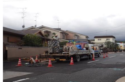
写真16ー車上プラント
