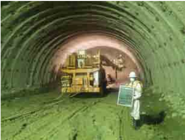
写真-5 支保 No.125 の補助工法施工状況
