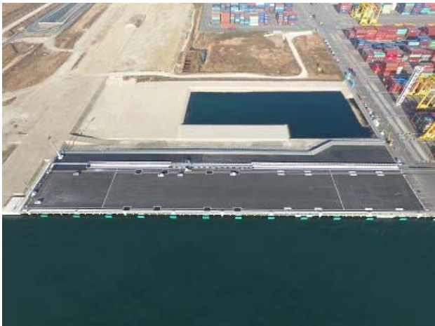
写真-8 C12延伸部岸壁工事完成状況
