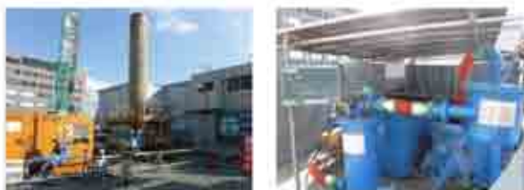
図-6 ストレイナーの施工状況 図-7 VPRWの施工状況
