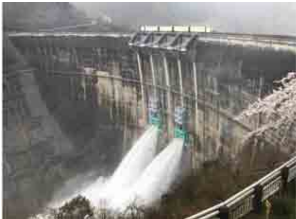
写真-2 主放水ゲート放流状況
