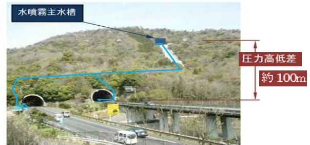
図-4 水噴霧主水槽設置状況
