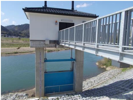
図-1 ゲート設備(福知山 矢津川樋門)
