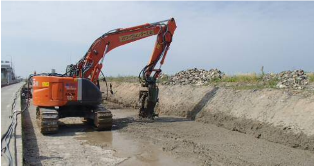
図-9 パワーブレンダー工法 施工状況
