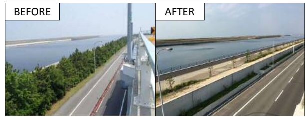
図-14 防潮壁の築造前と築造後
