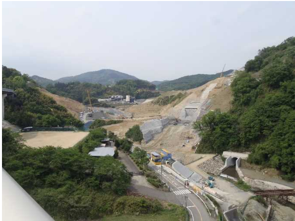
写真－4 安威川ダム施工状況
