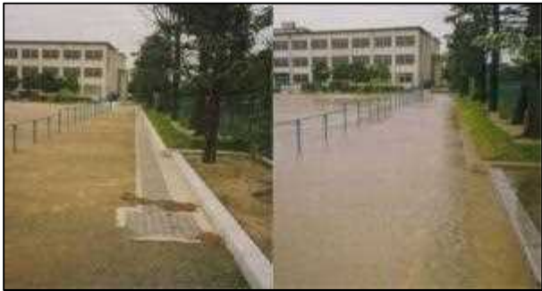
写真－5 校庭貯留（左：晴天時、右：降雨時）
