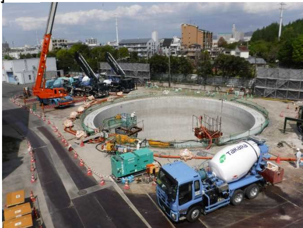
写真－3 北部地下河川施工状況
