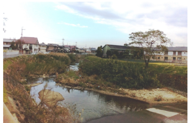
写真-6 河床整正 施工前の状況（佐野川）
