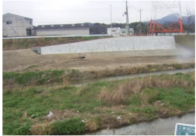
写真－８ 常設の工事用進入路設置の取組（梅川）
