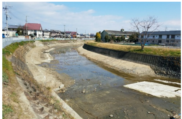
写真-7 河床整正 施工後の状況（佐野川）
