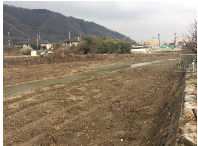
写真-5 余野川での滞筋施工後の状況
