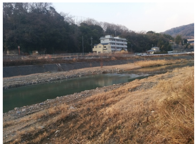
写真-2 施工後の状況
