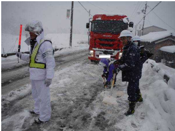
写真-4 現地対策班による除雪作業の状況
