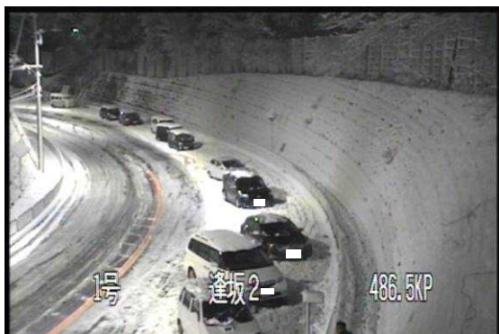
写真-1 2015年1月1日逢坂峠スタック状況
