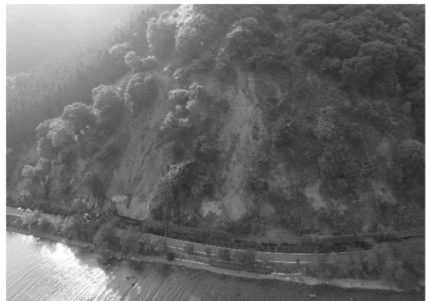
図-5 県道 西浅井マキノ線の被災 H27.7.29撮影
