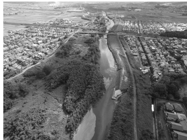
図-7 河道内堆砂・河川内立木繁茂の状況 H27. 10. 13撮影
