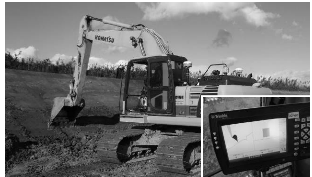
図-12 ICT建設機械（MGバックホウ）
