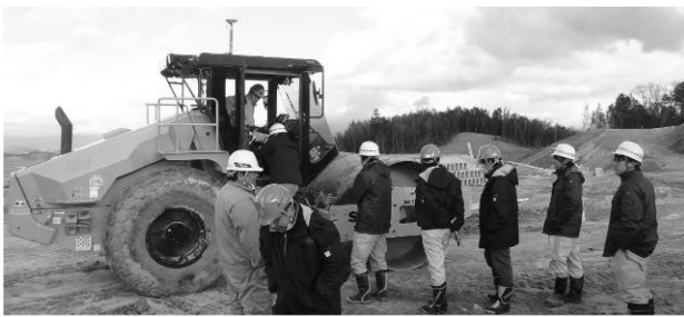
図-2 ICT建設機械の視察
