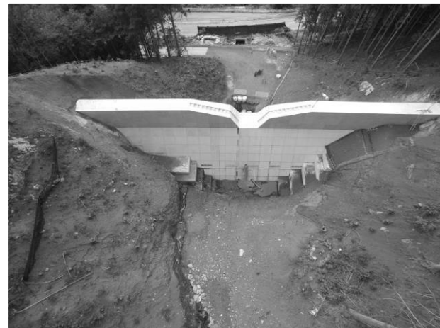
図-8 砂防えん堤の堆砂状況（訓練） H27. 10. 22撮影
