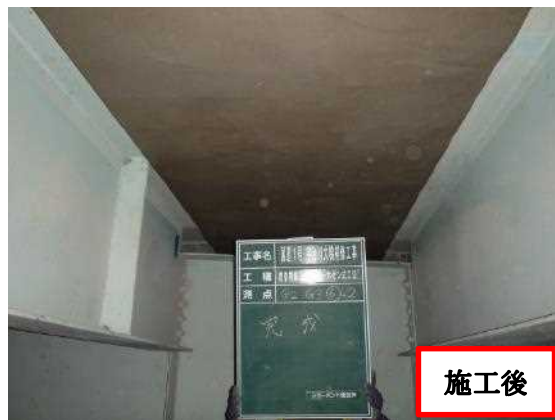
写真2 宇治川大橋施工前後写真
