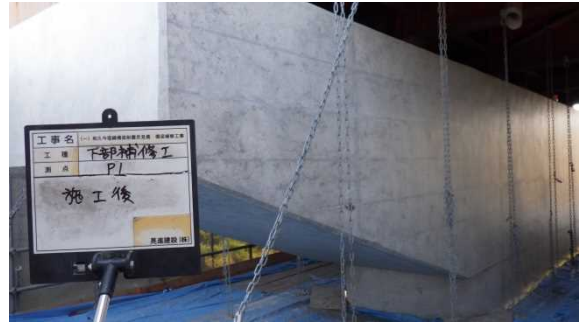
写真-4 京見橋の下部工（施工後）
