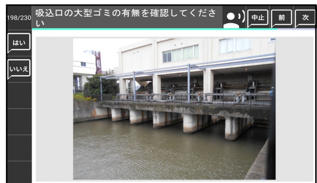
写真2 現場状況確認シナリオ
