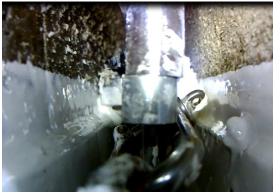
写真-8 止水材を塗布する状況（遊間内部）
