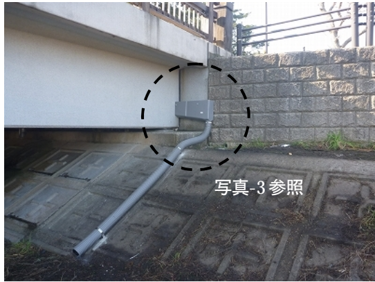
写真-2 簡易排水装置の設置状況
