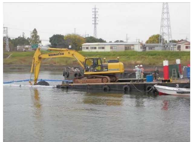
図-1 浚渫工事の様子
