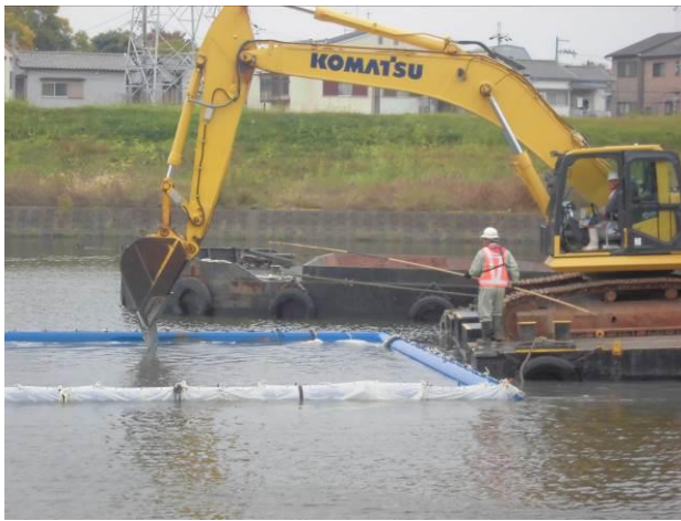
図-7 重機周辺での掘り残し確認
