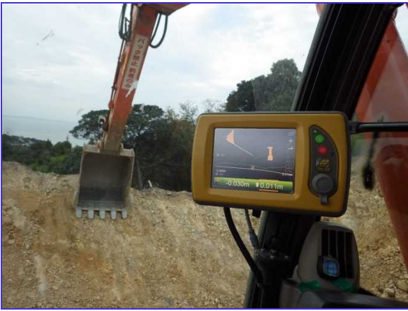
写真-6 切土作業状況写真
