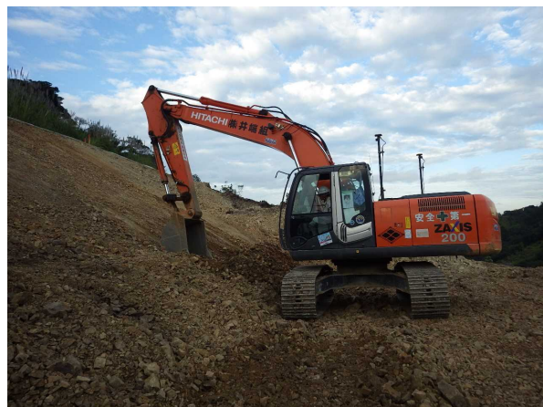
写真-5 切土作業状況写真
