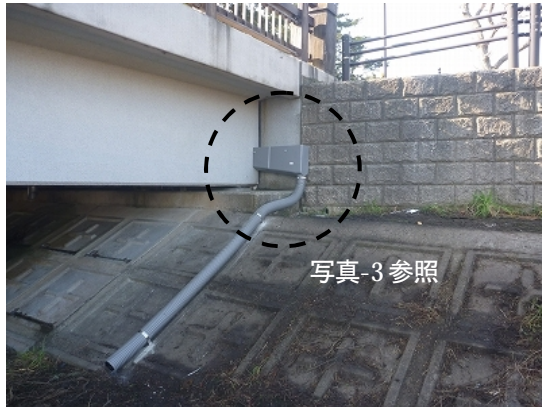
写真-2 簡易排水装置の設置状況
