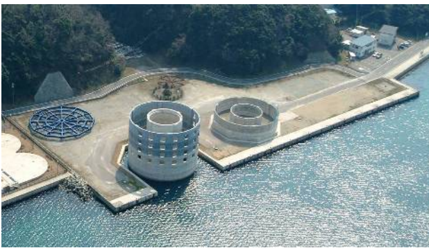
図4 陸上製作ヤード
