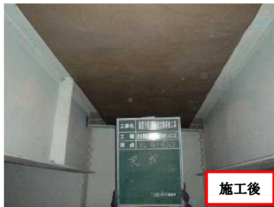
写真2 宇治川大橋施工前後写真
