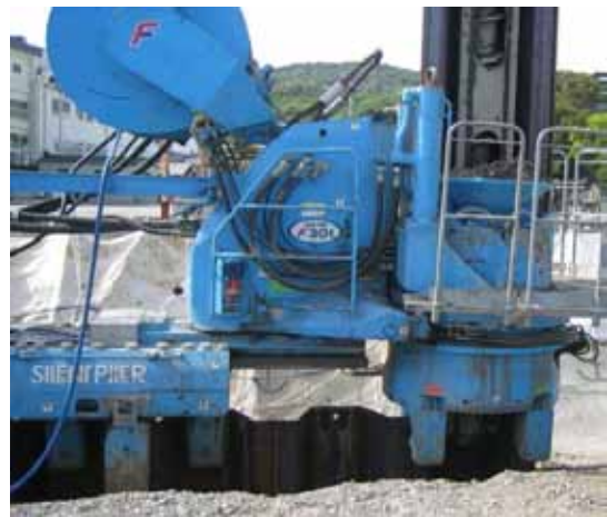
写真-9 鋼矢板打設状況
