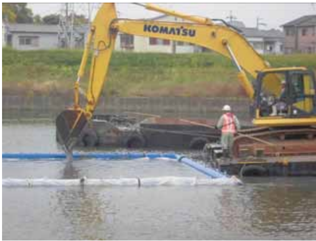
図-7 重機周辺での掘り残し確認
