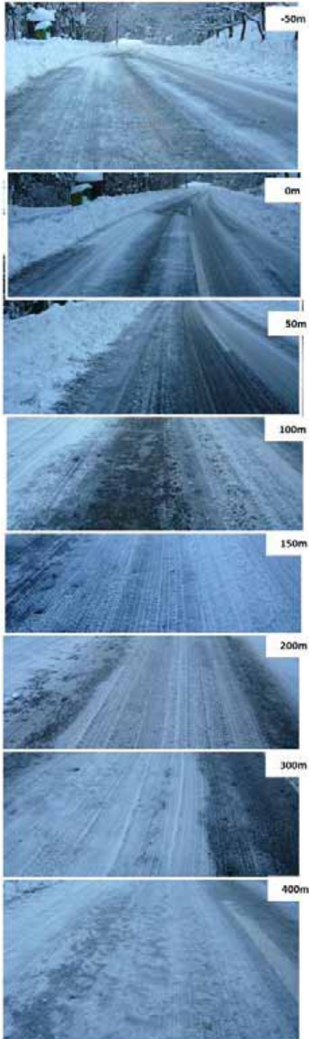
写真-3 観測点の路面の改質状況
