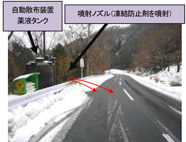
写真-1 凍結防止剤散布装置の設置状況（県道）
