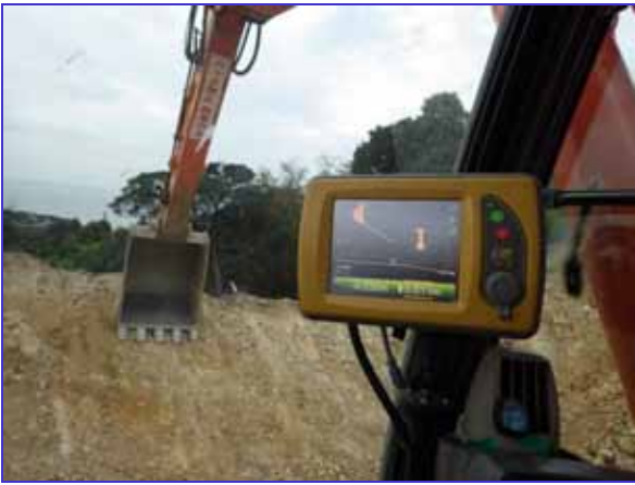
写真-6 切土作業状況写真
