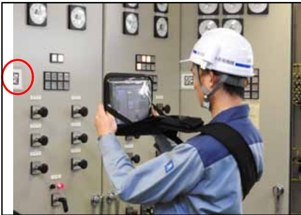
写真1 AR マーカー貼付・読込状況
