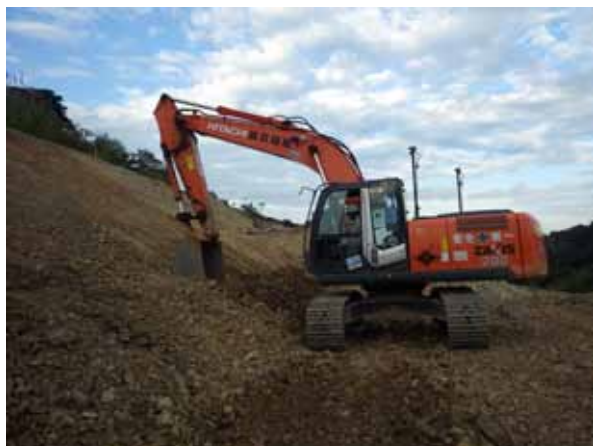
写真-5 切土作業状況写真
