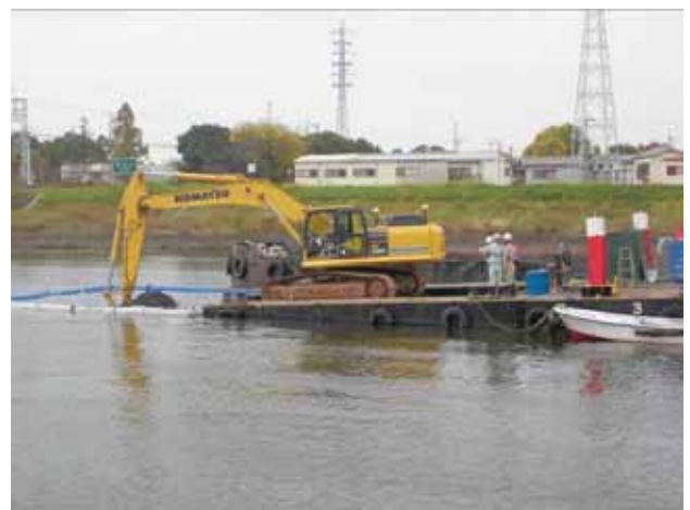
図-1 浚渫工事の様子
