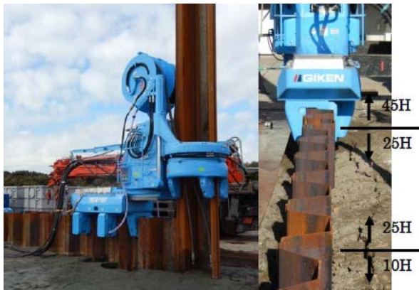
写真-5 打設試験状況（油圧圧入工法）
