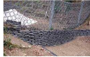
写真-22 縮災土のうを恒久対策として活用
