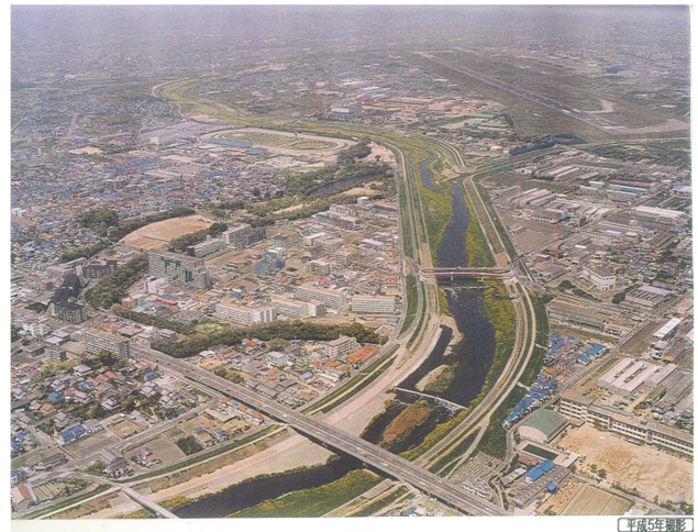
図-1 航空写真(利倉捷水路付近を下流側から撮影)
