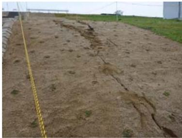
写真10 降雨で流れた土砂
