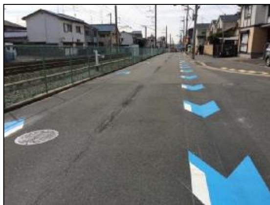
写真-6 事例) 自転車レーン(走行空間の明確化)の設置
