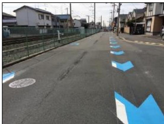
写真-6 事例）自転車レーン（走行空間の明確化）の設置
