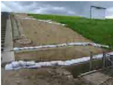
写真11 土砂流れ対策後
