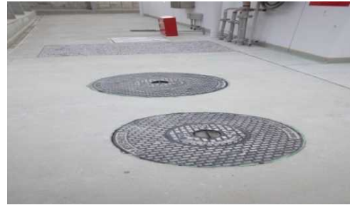
図4-4 地下タンク埋設(2000L)
