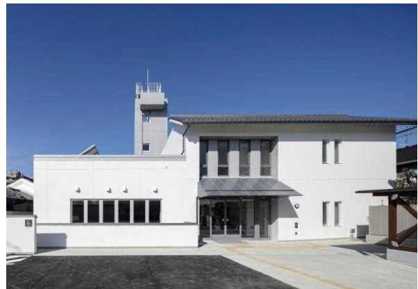
図1-2 奈良地方気象台(東側)(新築)
