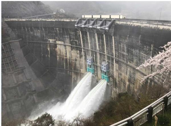
写真-2 主放水ゲート放流状況
