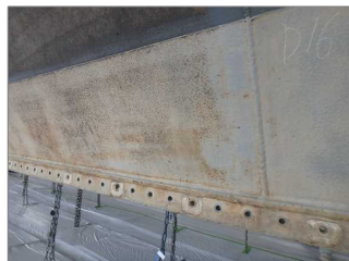
写真8 ガラスフレク塗装面(H28) (D面 下段扉スキムプレート)
