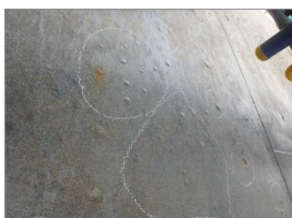
写真7 塗装のふくれ(H28) (C面 下段扉スキムプレート)
