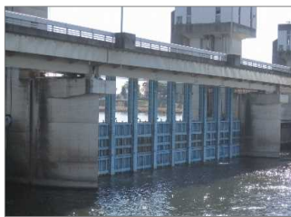
写真3 予備ゲート設置状況
