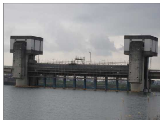
写真4 足場設置状況
