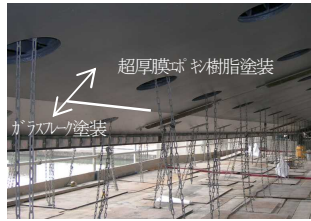
写真2 ガラスフレーク塗装後
