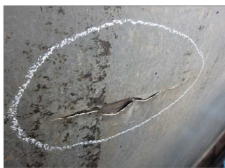
写真5 塗装のわれ(H28) (G面 下段扉背面)
