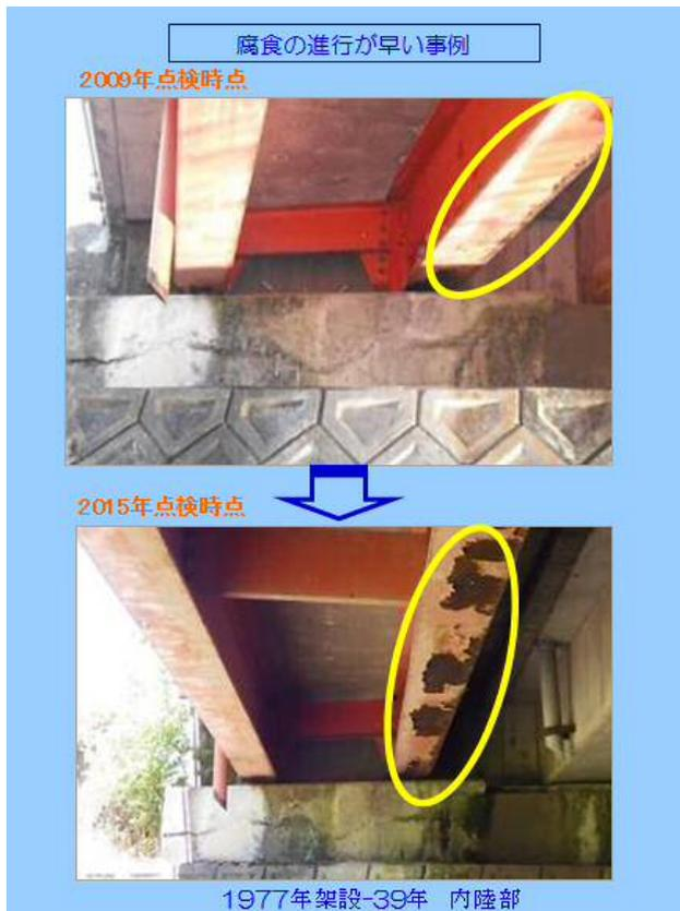
写真-2 鋼橋の腐食の進行状況
