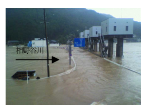
写真-2 鮎田水門付近の状況
