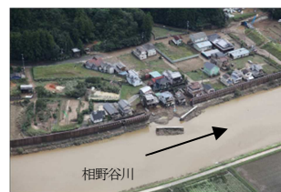
写真-3 高岡輪中堤の転倒
