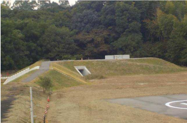
写真-2 研修用不具合堤防 (H28.10.28撮影)
