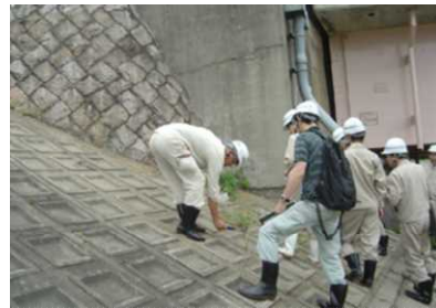
写真-1 現地での点検実習状況 (平成26年度 河川管理研修)
