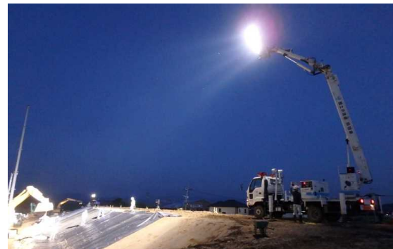
写真2 熊本地震による災害復旧活動
