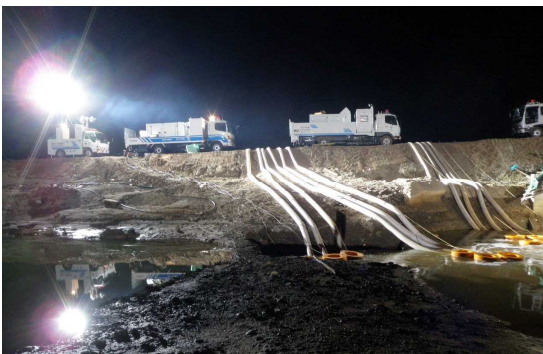
写真1 東日本大震災による災害復旧活動
