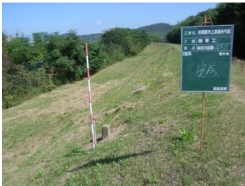
図-3 刈り放し後の堤防法面
