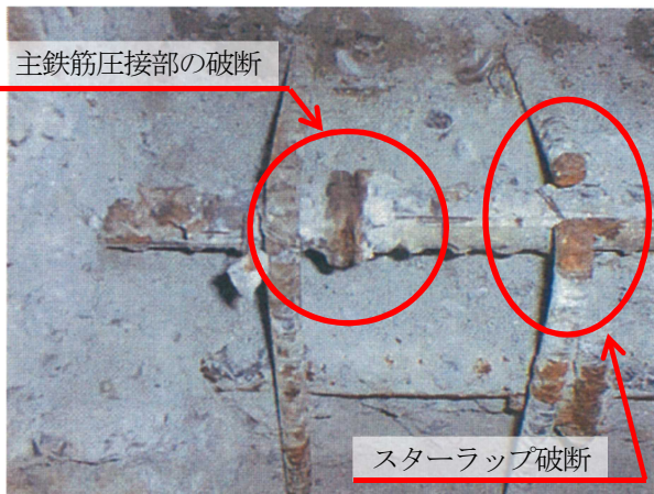
写真-1 鉄筋破断の状況 (はつり出し後)
