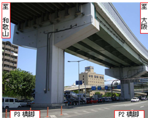
写真-3 堺高架橋の現況
