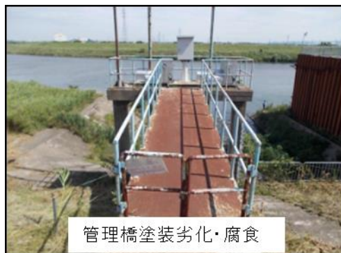
図-7 塗装劣化・腐食 健全度評価△3
