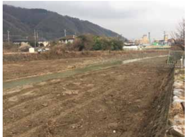
写真-5 余野川での滞筋施工後の状況
