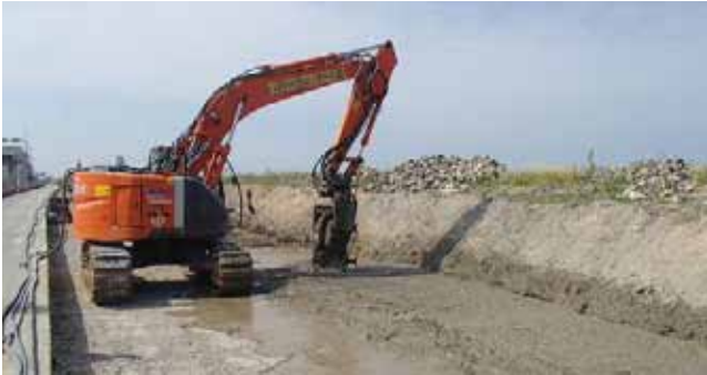
図-9 パワーブレンダー工法 施工状況
