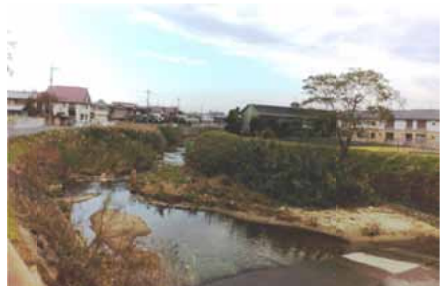
写真-6 河床整正 施工前の状況 (佐野川)
