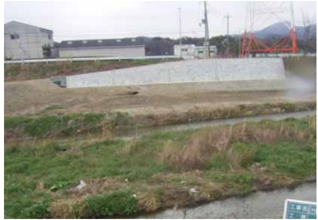
写真-8 常設の工事用進入路設置の取組（梅川）
