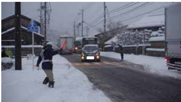
写真5 片側交互規制の状況
