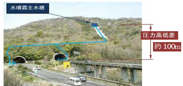
図-4 水噴霧主水槽設置状況
