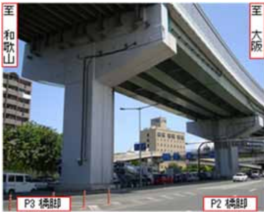
写真-3 堺高架橋の現況
