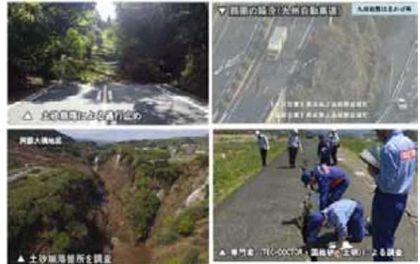
図-7 寸断された道路網の一例
