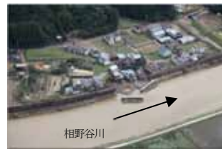
写真-3 高岡輪中堤の転倒
