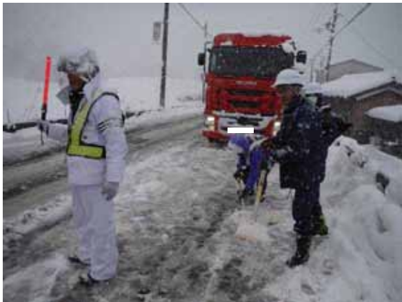
写真4 現地対策班による除雪作業の状況
