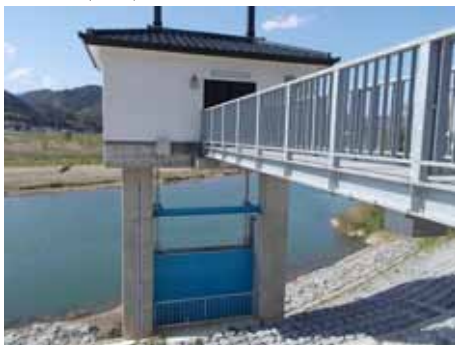
図-1 ゲート設備(福知山 矢津川樋門)
