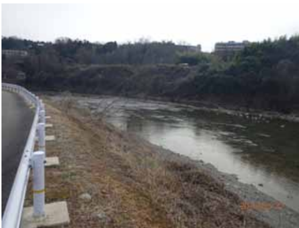
写真-3 施工から1年後の状況
