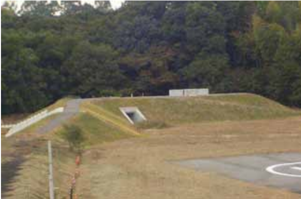
写真-2 研修用不具合堤防 (H28.10.28撮影)
