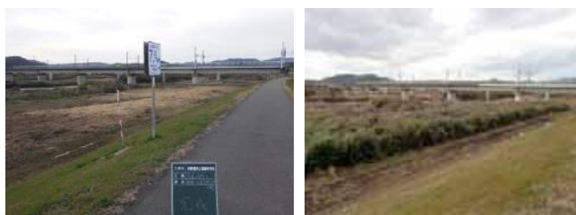
図-8 竹林の再繁茂 (左：施工直後 右：施工後約1年)
