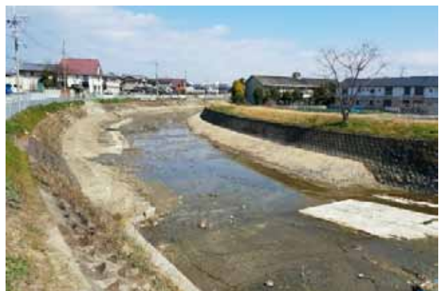
写真-7 河床整正 施工後の状況 (佐野川)
