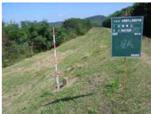
図-3 刈り放し後の堤防法面
