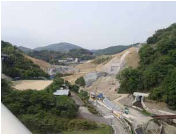
写真-4 安威川ダム施工状況
