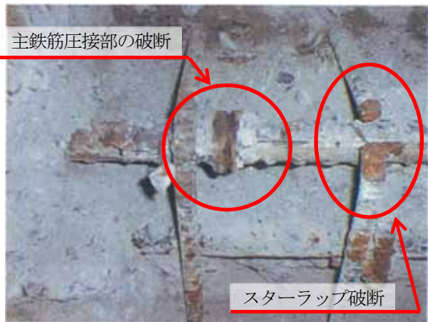
写真-1 鉄筋破断の状況 (はつり出し後)
