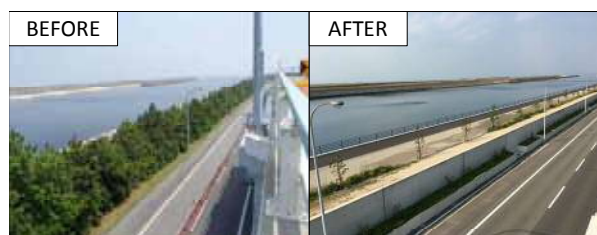
図-14 防潮壁の築造前と築造後
