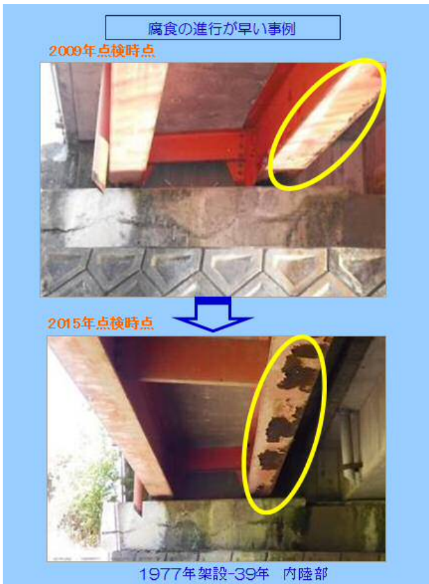
写真-2 鋼橋の腐食の進行状況
