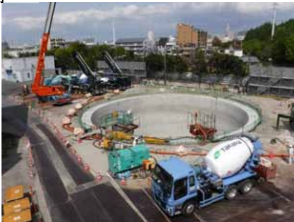
写真-3 北部地下河川施工状況
