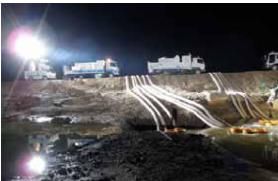
写真1 東日本大震災による災害復旧活動
