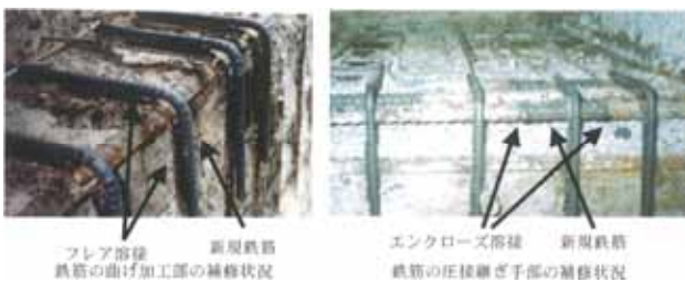
写真-2 鉄筋補修状況
