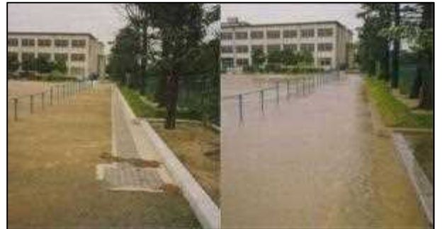
写真-5 校庭貯留（左：晴天時、右：降雨時）
