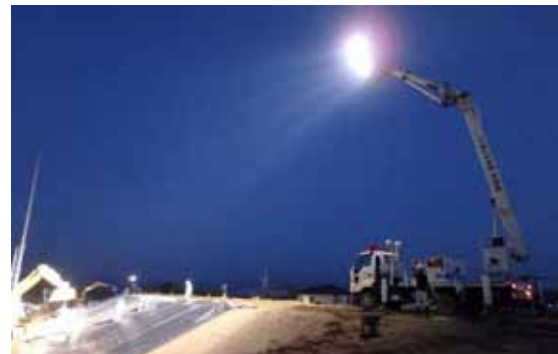
写真2 熊本地震による災害復旧活動
