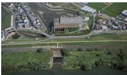
図-1 河川用機械設備
