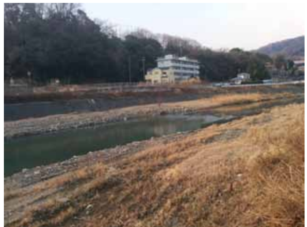
写真-2 施工後の状況
