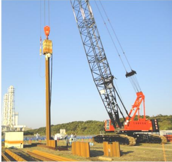
写真-1 バイブロハンマ工法による鋼矢板打設状況
