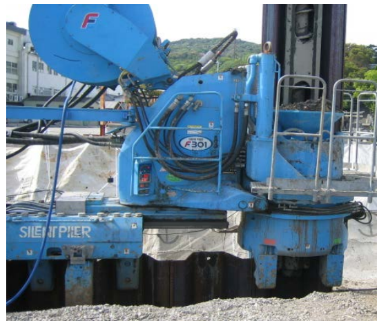
写真-9 鋼矢板打設状況
