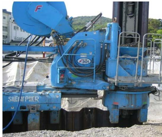
写真-9 鋼矢板打設状況
