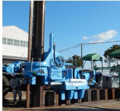
写真-2 油圧圧入工法による鋼矢板打設状況
