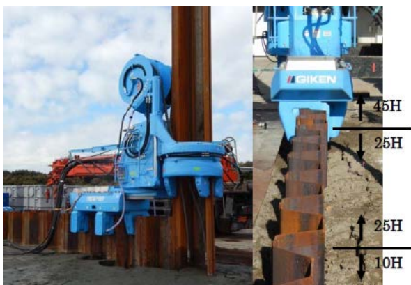
写真-5 打設試験状況（油圧圧入工法）
