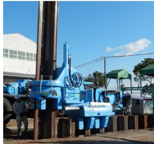
写真-2 油圧圧入工法による鋼矢板打設状況
