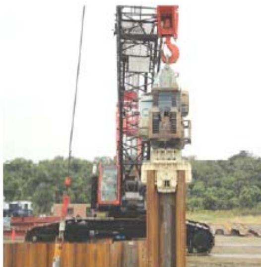
写真-4 打設試験状況 (パイプロハンマ工法)
