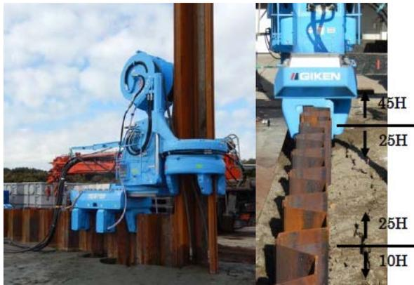
写真-5 打設試験状況（油圧圧入工法）
