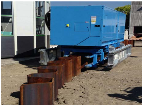
写真-3 ノンステージ圧入工法の 施工状況
