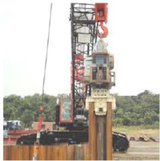
写真-4 打設試験状況 (パイロハンマ工法)
