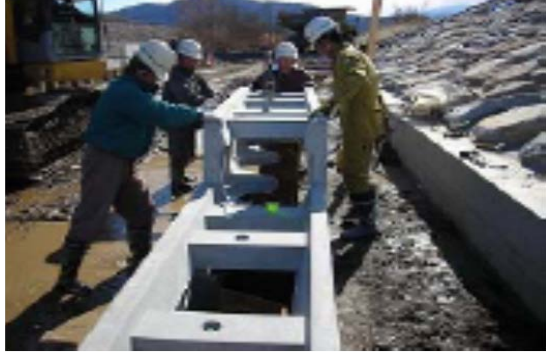
写真-7 ハット形鋼矢板へのプレキャスト笠コン実施事例
