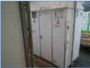
写真-1 快適トイレ 現場に設置(左)
