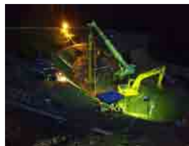
写真-10 護岸工事の夜間作業状況
