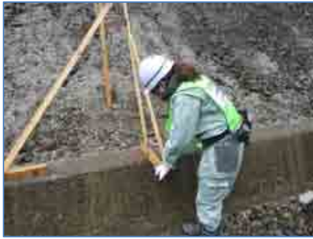
写真-7 作業状況
