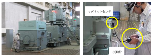
写真-2 振動測定実施状況
